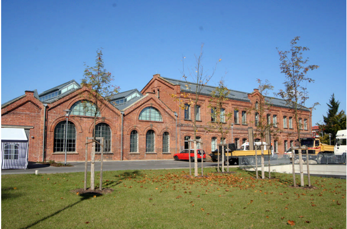
“Ziegelbau”, Teil einer ehem. Fabrik für Bucheinbandstoffe („Kaliko“). Eröffnung als Kongresszentrum 2004, Arch. Prof. Eberhard Schunk, München. Foto Thomas Beese 2005
